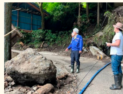
長野市鬼無里地区の災害現場を視察
